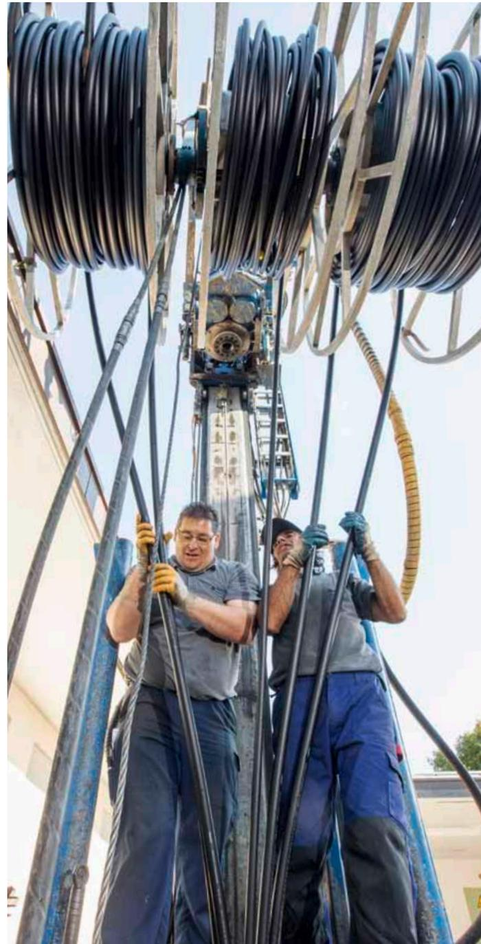
Bei der Schaubohrung im Spätsommer wurden die Erdsonden für die Wärmepumpen-Heizung gesetzt.
